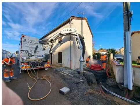
Sur la fin d'année, nous avons obtenu un marché à CONDAT LES MONTBOISSIER, situé au bourg, nous avons en charge la réhabilitation des réseaux assainissement et pluviales, le renouvellement de l'eau potable, et l'enfouissement des réseaux secs, (merci Quentin pour les
