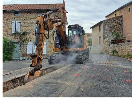
Également à SOLIGNAT pour le SME DE LA REGION d'ISSOIRE afin de réaliser une extension d'eau potable sur 900 ml à la trancheuse. Sur MUROL également où nos multiples compétences nous ont permis de réaliser simultanément l'extension des réseaux secs au village de Chautignat.
