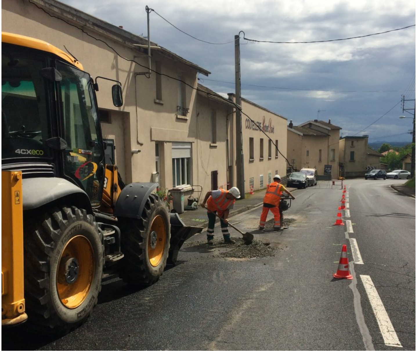
PHASE 2 : Réalisation des terrassements en traditionnel et technique douce
